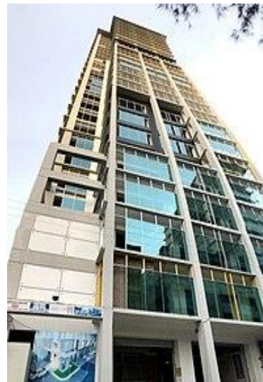
(d) Tower-71, Chattogram Height: 104 m Lat: 22.3272836 Long: 91.8138975
