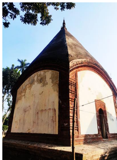
(d) North west corner
